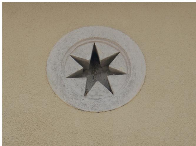
Cette photo de l'œil de bœuf permet de se rendre compte qu'il s'agit d'une ouverture dans un mur et que la partie centrale de l'étoile est un vide dans la pierre.
